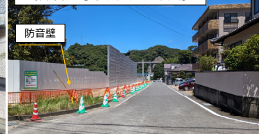
仮設工事完了後の現場
