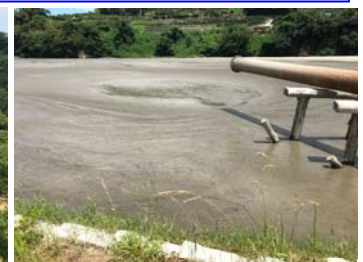
空気圧送による土砂搬入
