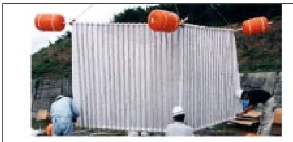
写真4 多重メッシュ根圏保護ネットの例
