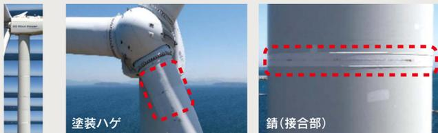
風車全体、詳細箇所の外観上の損傷(錆、塗装剥げ、変形)の把握が可能です。
