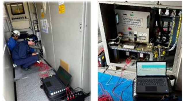
図5 タワー基部での測定状況(国内発電所での実績)
