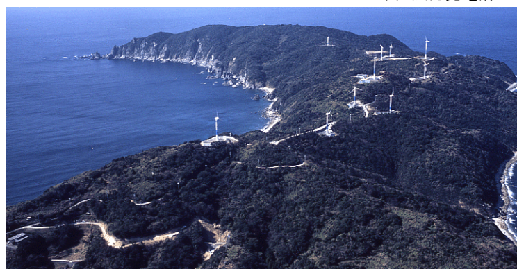
(b)B風力発電所
