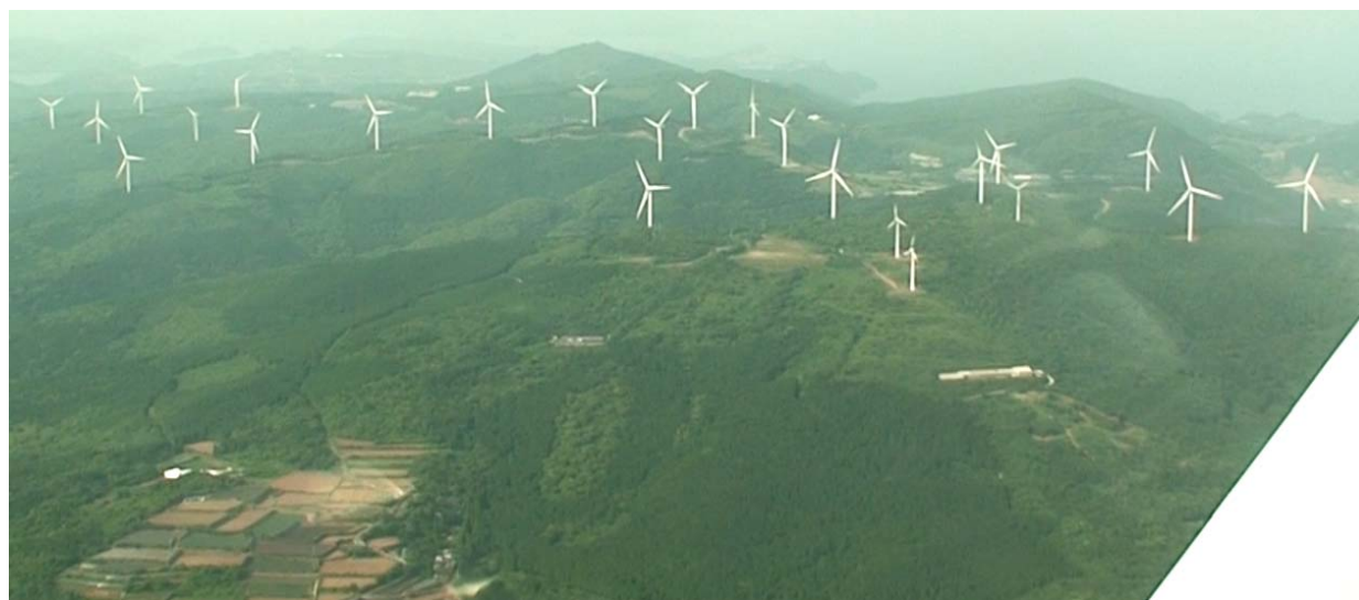
(a)A風力発電所
