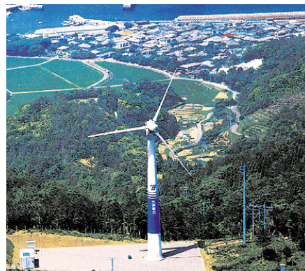
(c)C風力発電所
