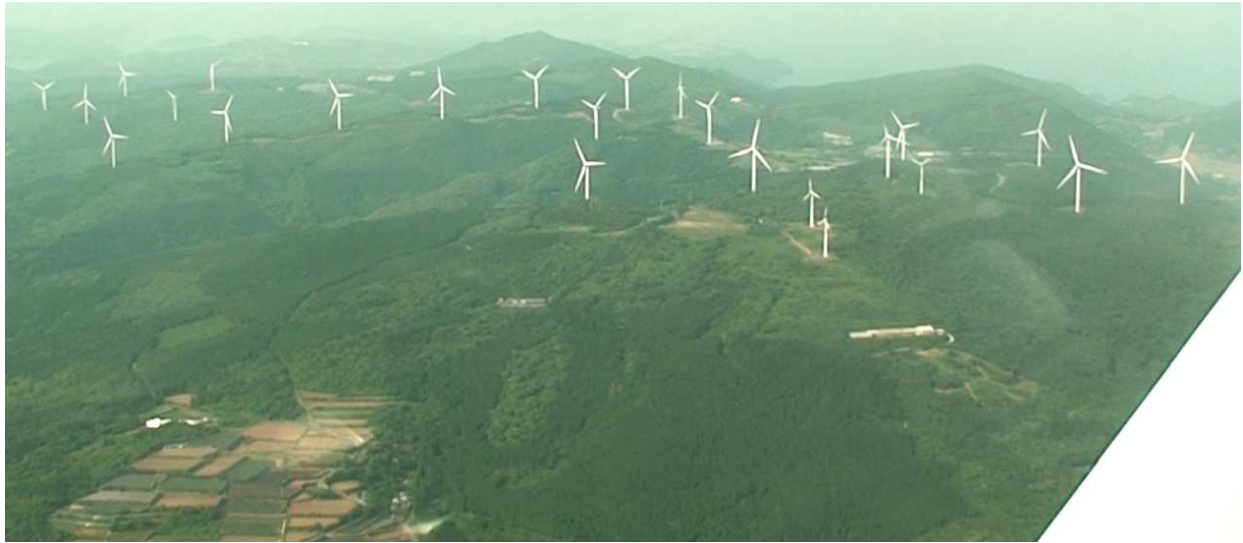
(a)A風力発電所
