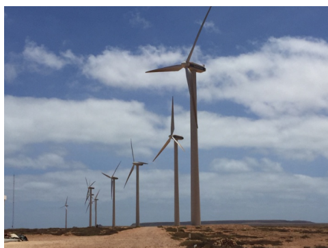
図2 カーボヴェルデ共和国 Sal 島 VESTAS 製風車 850kW×9 基
