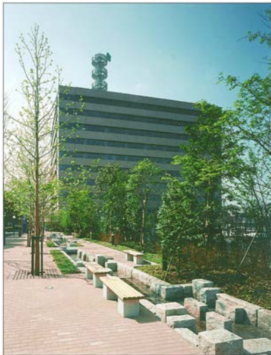
北東面全景（せせらぎ）
