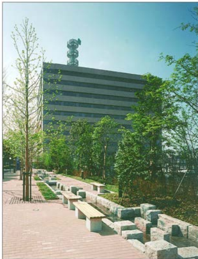
北東面全景（せせらぎ）
