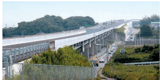
福岡前原道路高架橋
