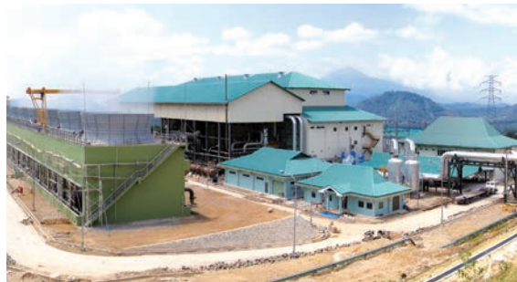
インドネシア共和国 ウルブル地熱発電所 1・2号機新設工事
