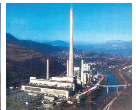
ボスニア:カカニ石炭火力発電所
