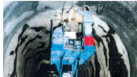
道路トンネル空洞調査
