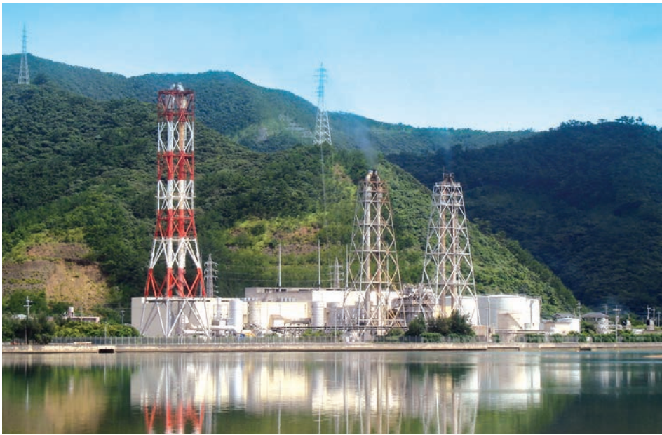
九州電力株式会社 竜郷発電所(内燃力)
