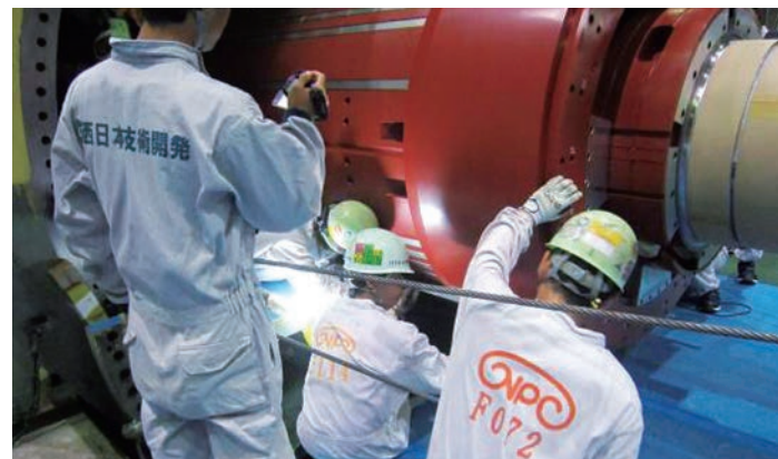
発電機組立作業への立会
