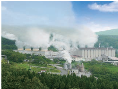
九州電力株式会社 八丁原地熱発電所
